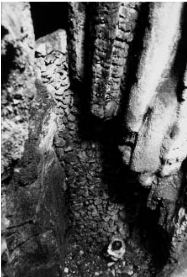
Foto 2: Fotografia presa a poc d'iniciar el descens al Clot de Neu Gran de sa Rateta (Bunyola), avenc natural que assoleix una fondària de 16 metres. Al seu interior s'hi localitza un gran mur de pedra seca, de 7 metres d'alçada, construït per tal de condicionar la cavitat per a les tasques d'emmagatzematge de neu.
